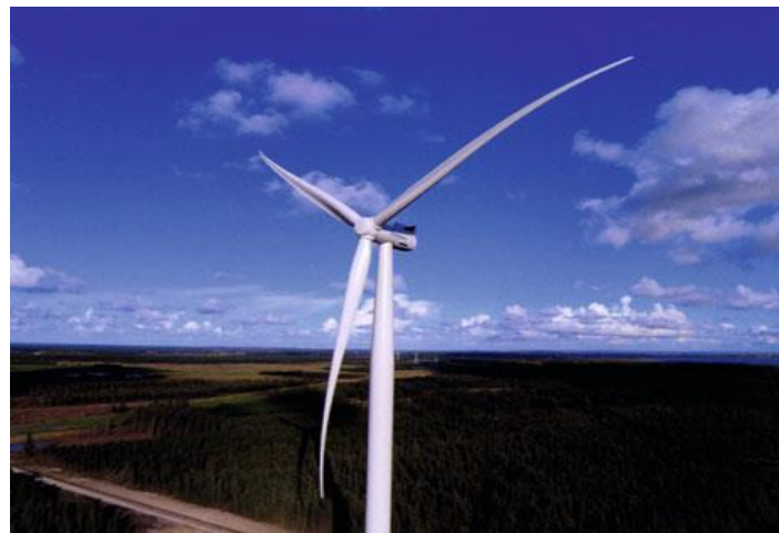
Şekil 1.9 75m kanat uzunluğuna sahip rüzgâr türbini [48].
