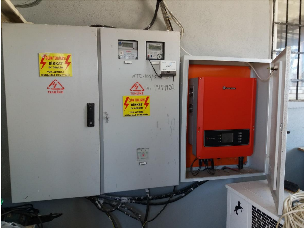
Şekil 5.3 Tesiste kullanılan evirici ve pano
