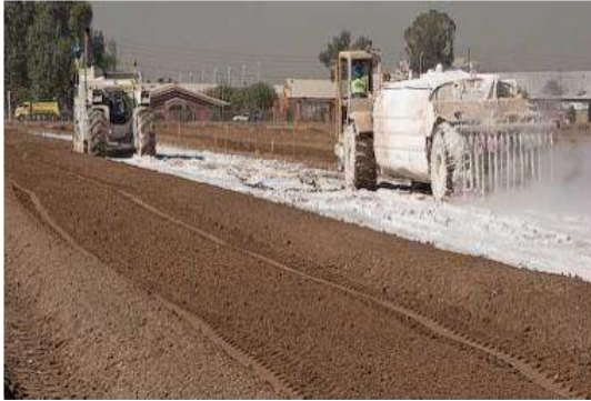
c-Dağıtıcının kireci zemin yüzeyine sermesi
