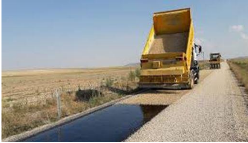
Şekil 3.3: Yüzeysel kaplama saha uygulaması [30].
