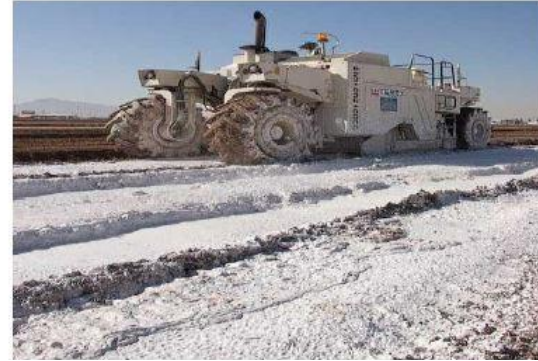
d-Kirecin zemine karıştırılması
